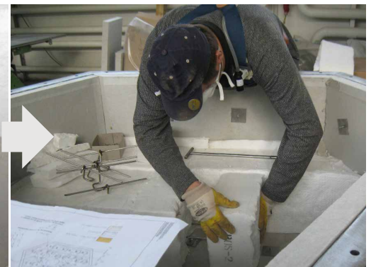
Fig. 12: Press module onto pins
