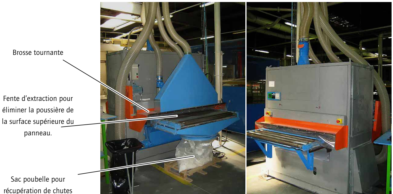
Ponceuse connectée à la ventilation / ponceuse horizontale
