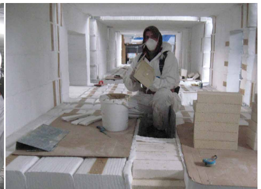
Fig. 7 : Installation de nappes aiguilletées et de modules
