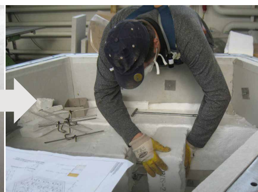
Fig. 12: Mise en place du module sur les broches d'ancrage
