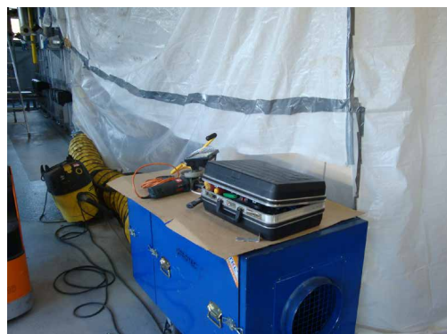
Fig. 3 : Enceinte en dépression – Système de filtration de l'air avec filtre haute efficacité
