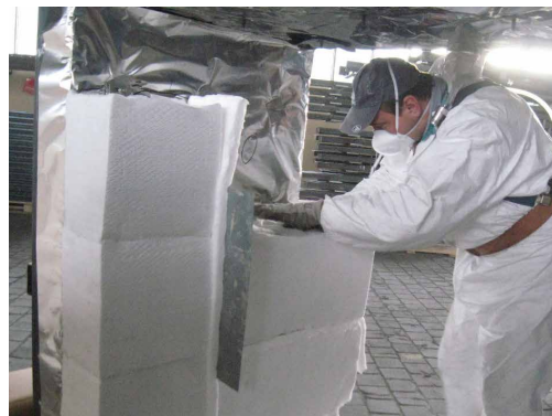
Fig. 7 : Installation de nappes aiguilletées et de modules
