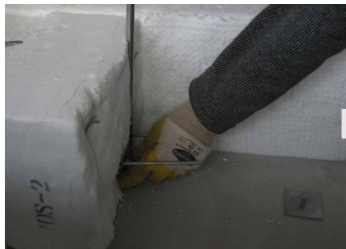
Fig. 9: Mise en place de l'ancrage métallique
