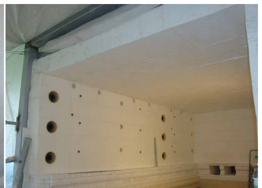
Fig. 4 : Après l'installation - fours industriels (avec modules et briques)
