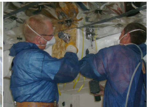
Fig. 1 : Zone de travail fermée avec système de filtration
