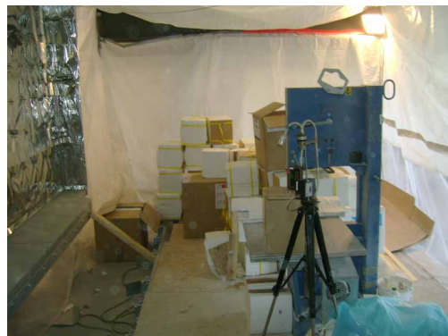
Fig. 1 : Zone de travail fermée avec système de filtration
