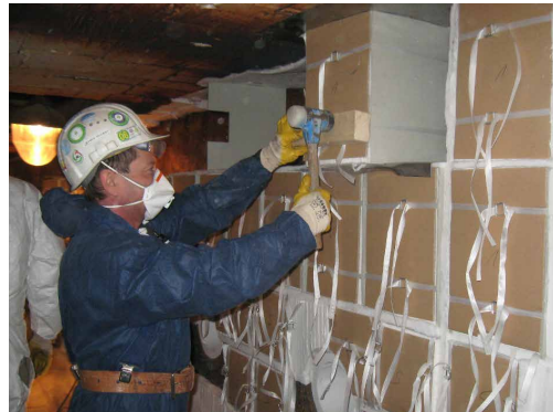
Fig. 5: Installation de modules préfabriqués
