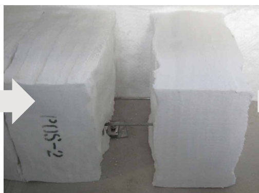
Fig. 11: Installation du module suivant
