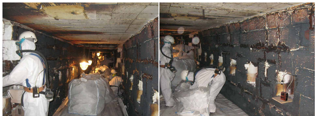
Abb. 3&4: Entferntes Material in versiegelten Plastiktüten. Reduzierung des Faserstaubes
