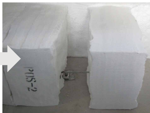
Abb. 11: Installation des nächsten Moduls
