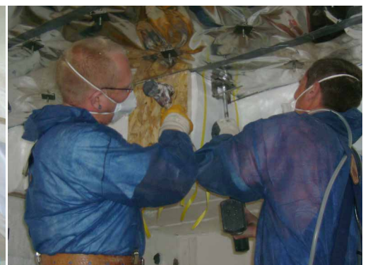
Abb. 2: Installation im Arbeitsbereich
