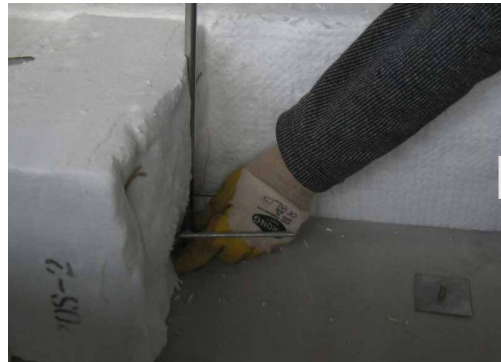
Abb. 9: Anbringen von Kammerkern aus Metall
