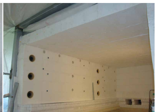
Abb. 4: Nach der Installation - Industrieofen (mit Modulen und Blöcken)
