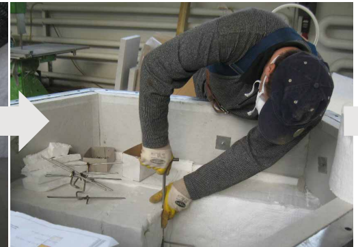
Abb. 10: Befestigen eines Ankersystem
