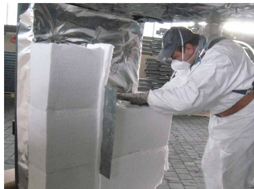
Abb. 7: Installation von Matten und Modulen
