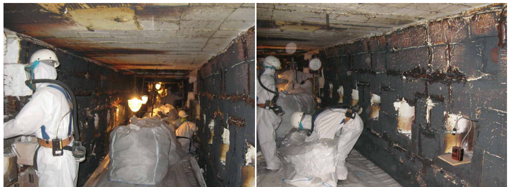
Photos 3&4 : Matériaux enlevés placés dans des sacs en plastique scellés afin de réduire l'exposition à la poussière fibreuse
