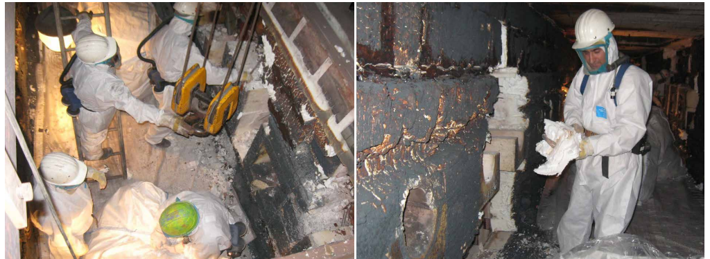
Photos 1&2 : retrait de modules LIHT des broches métalliques d'ancrage
